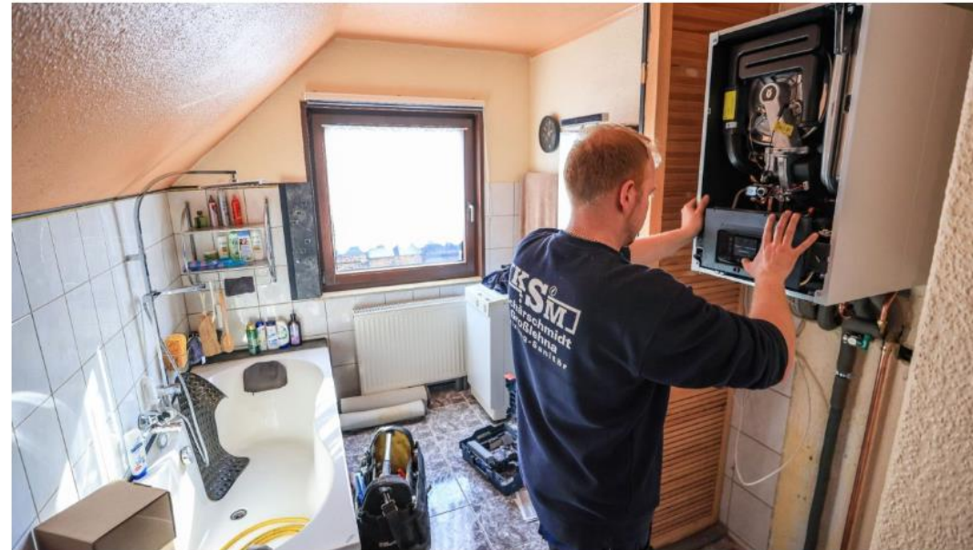
Ein Mitarbeiter einer Sanitär- und Heizungsbaufirma installiert eine moderne Gasbrennwerttherme in einem Einfamilienhaus.
