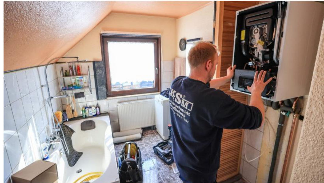
Ein Mitarbeiter einer Sanitär- und Heizungsbaufirma installiert eine moderne Gasbrennwertherme in einem Einfamilienhaus.
